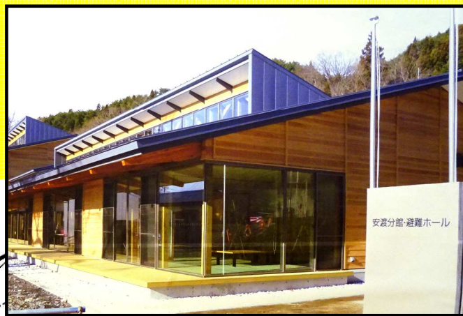
12月に竣工した「安渡公民館・避難ホール」
